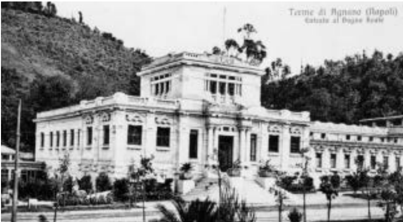
Fig. 4. Giulio Ulisse Arata, Bagno Reale, Terme di Agnano, 1908.
