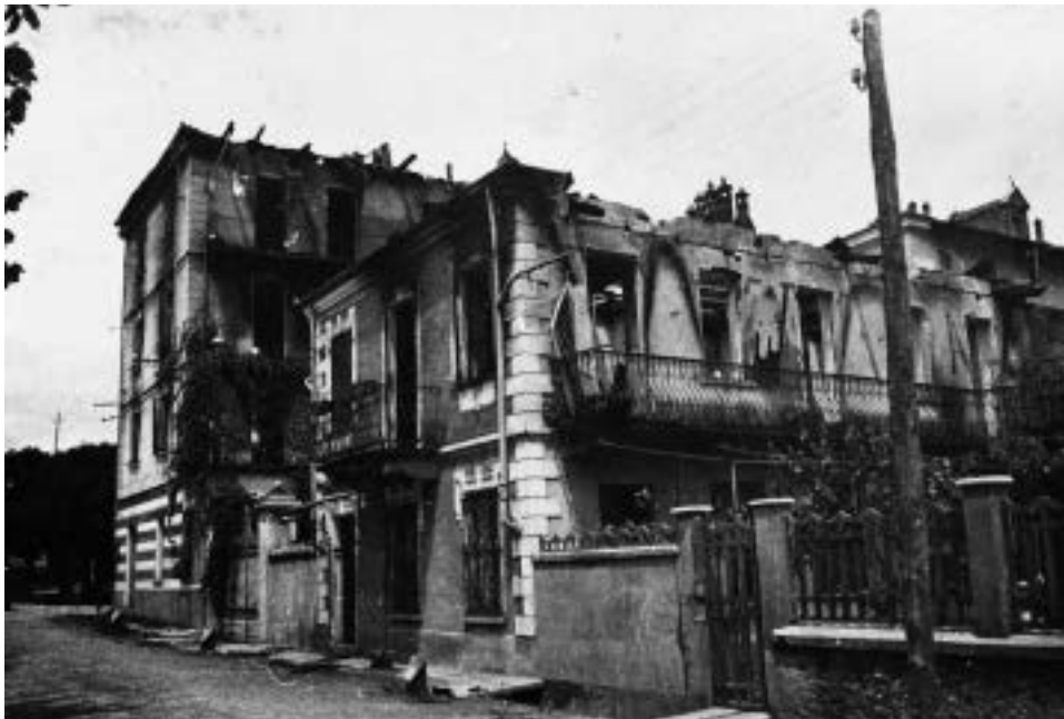
Fig. 4. 1 luglio 1944: un edificio dell'insediamento storico di Barge dopo l'incendio appiccato dai tedeschi (archivio fotografico Galliano).
