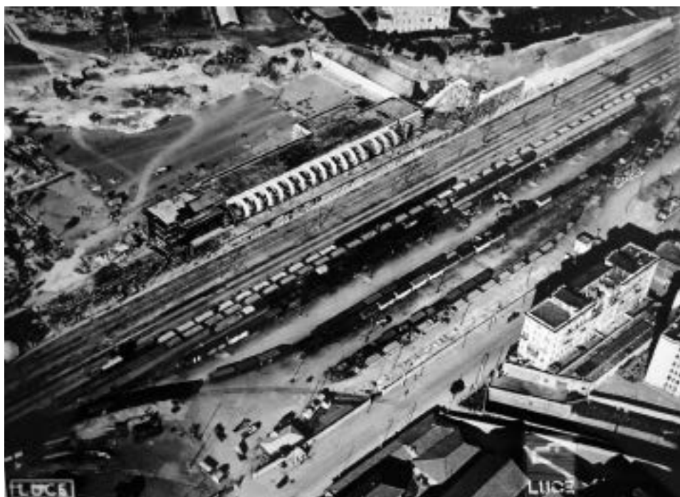
Fig. 18. La stazione Ostiense in una foto aerea del 4 aprile 1938 (Archivio Luce).
